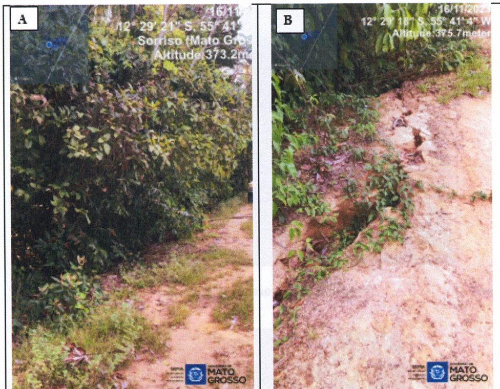
Figura 6. Talude de jusante
